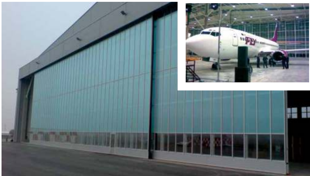
Ворота в помещении с наклонными полами
